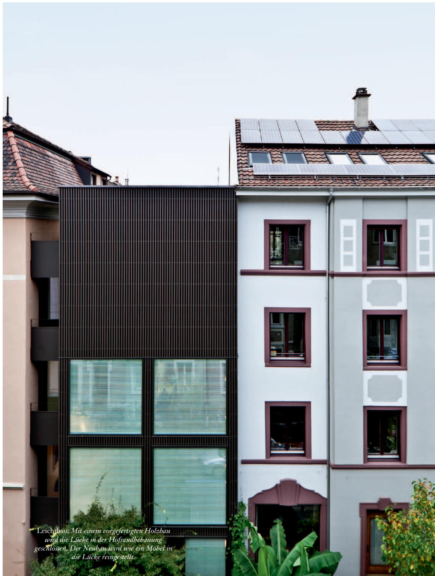
Leichtbau: Mit einem vorgefertigten Holzbau wird die Lücke in der Hofrandbebauung geschlossen. Der Neubau wird wie ein Möbel in die Lücke reingestellt.
